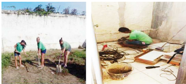
Figura 19 – Manutenção de Capina e Colocação de piso.
